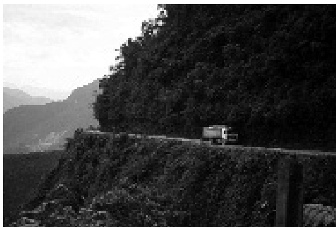
Fotografía n° 3: El antiguo camino carretero a Yungas, actualmente en proceso de sustitución por la reciente apertura de la nueva vía, presentaba graves problemas de circulación y una elevada siniestralidad
